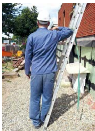
Figuur 5: Een eerste methode om de juiste hoek van de ladder te bepalen
