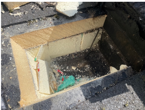
foto 60 - dampscherm niet doorgescheurd
