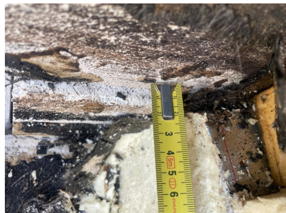
foto 61 - verschuiving 2de Ytongsteen
