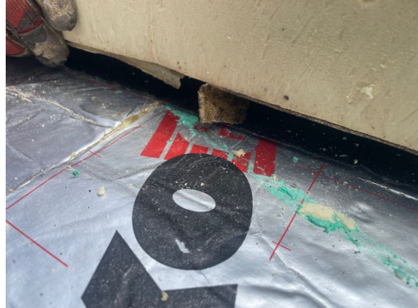
foto 30 - cachering ligt los op onderste isolatielaag
