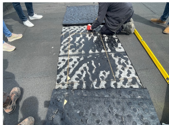
foto 28 - vrijmaken isolatieplaat
