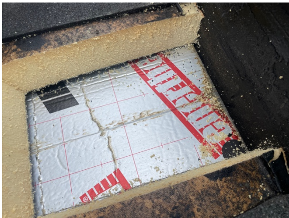
foto 51 - spanningen op bovenste isolatieplaat
