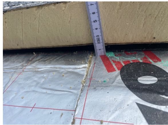
foto 40 - schotelvorming bovenste plaat
