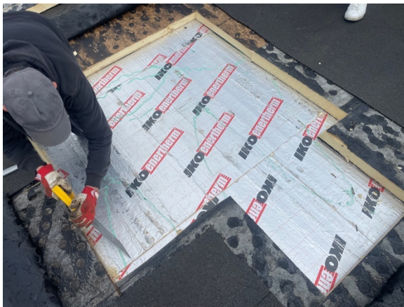
foto 41 - vrijmaken volledige isolatieplaat
