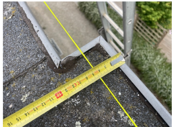
foto 14 - opmeting rechter zijgevel
