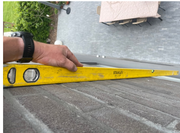
foto 20 - overhellen bovenzijde gevel
