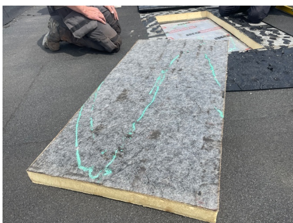
foto 37 - verlijming isolatieplaat
