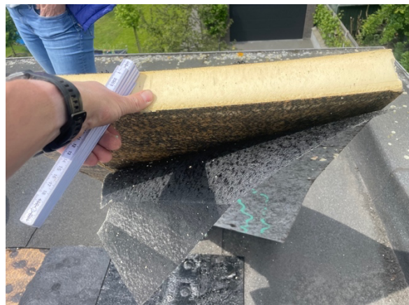
foto 32 - losse cachering onderzijde plaat
