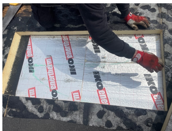
foto 38 - verlijming isolatieplaat
