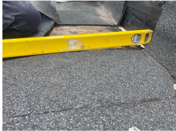
foto 50 - opbolling bovenste isolatieplaat
