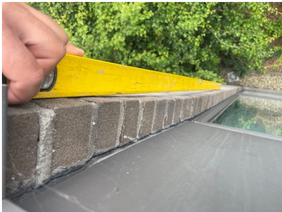
foto 19 - overhellen bovenzijde gevel
