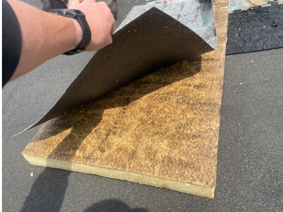
foto 29 - losse cachering onderzijde plaat
