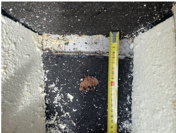
foto 55 - verschuiving opstand
