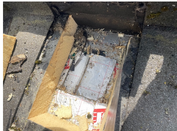
foto 59 - isolatie dmv reststukken
