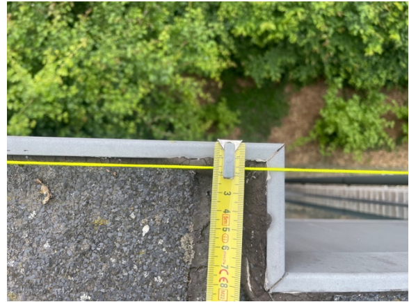
foto 12 - opmeting linker zijgevel
